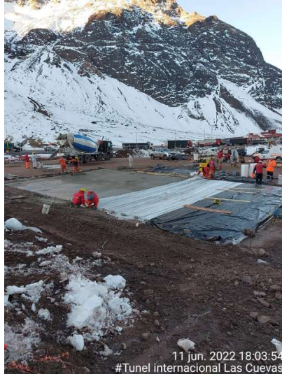
Fotografías de colado en alta montaña – Protección con triple pliegue de polietileno de burbujas
