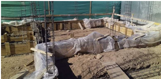
Fotografías de colado en condiciones de tiempo frío de viviendas – Protección de vigas de fundación y losas
