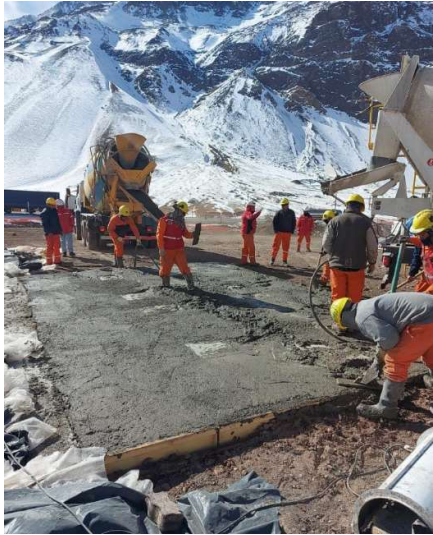
Fotografías de colado en alta montaña – Protección con triple pliegue de polietileno de burbujas
