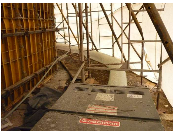
Fotografías de antena Aeroespacial con protección de carpas y calor perimetral
