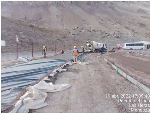
Fotografías de colado < 0 °C en pavimentos de alto tránsito y plateas – Protección con pluribol e aislant
