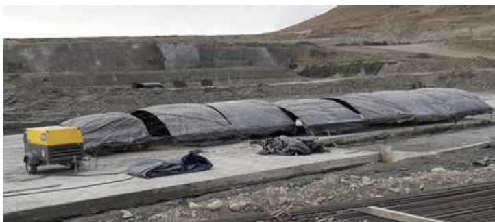
Fotografías de protección con carpas y calefacción en zonas de temperaturas bajas mantenidas
