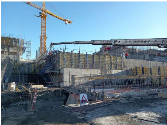
Fotografías de grandes presas – Protección de encofrados con poliuretano y mantas térmicas en losas EJEMPLOS DE PROTECCIÓN ACTIVA (Con “carpas”, microclimas y aporte de calor)
