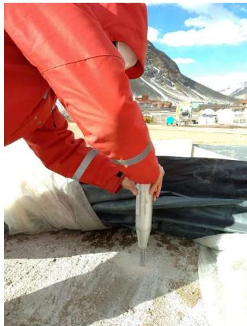
Ensayos no destructivos para medir el grado de endurecimiento de hormigones en tiempo frío
